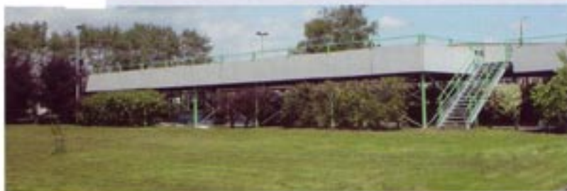
Belgium: the parking capacities at the airport were expanded with the system / Belgien: die Parkkapazitäten am Flughafen wurden mit dem System erweitert
