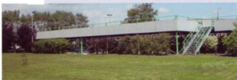
Belgium: the parking capacities at the airport were expanded with the system / Belgien: die Parkkapazitäten am Flughafen wurden mit dem System erweitert
